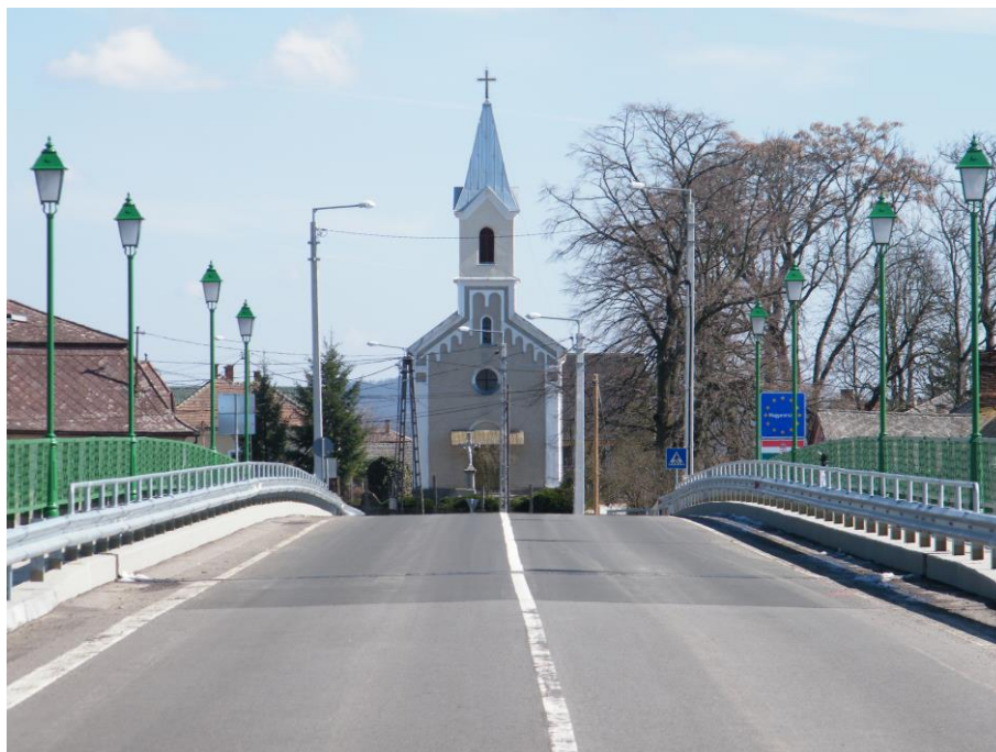
35. ábra: Ipoly-híd Szécsény-Pöstenypuszta és Petőpuszta (Pečov) között
