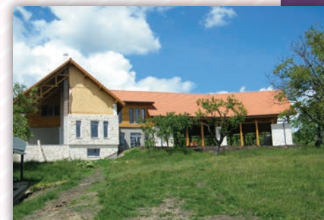
Az épülő képzési központ Válaszúton
